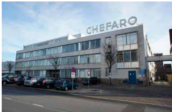
Chefaro gebouw aan de Keileweg in Rotterdam
